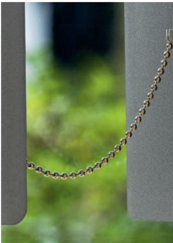
Raffiniert gelöst: Silberfarbige Verbindungsketten aus Metall verhindern selbst beim Wenden Schwingungen der Aluminium-Lamellen.
